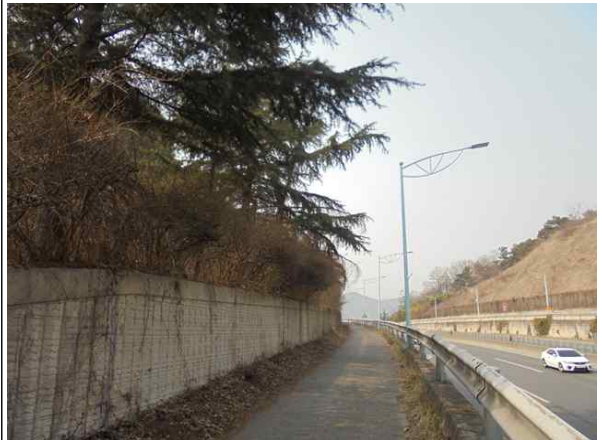
낙석방지울타리 및 하부 전경
