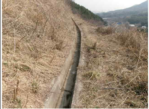
2소단 배수로 전경
