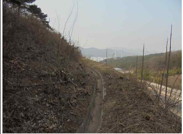
2소단 배수로 전경
