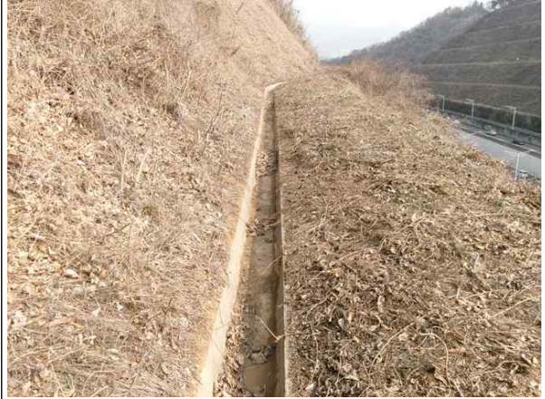
2소단 배수로 전경
