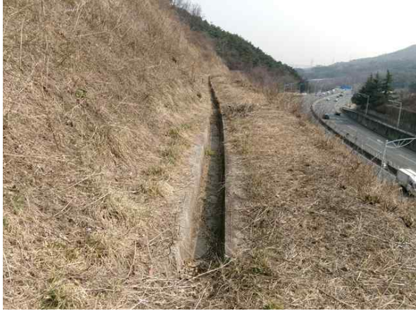
1소단 배수로 전경
