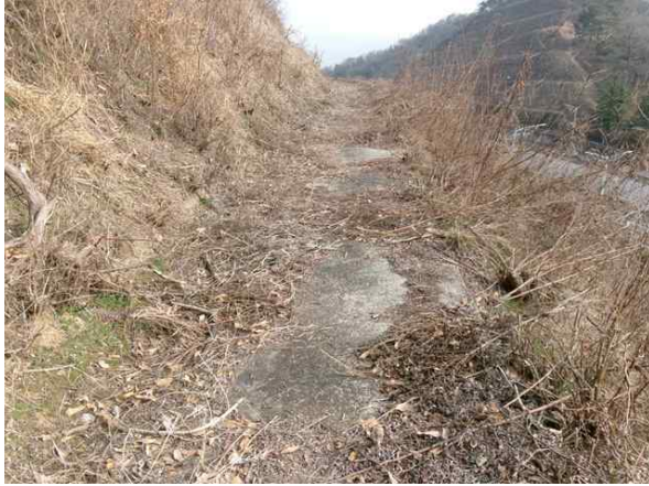
1소단 배수로 전경
