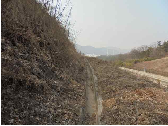
1소단 배수로 전경
