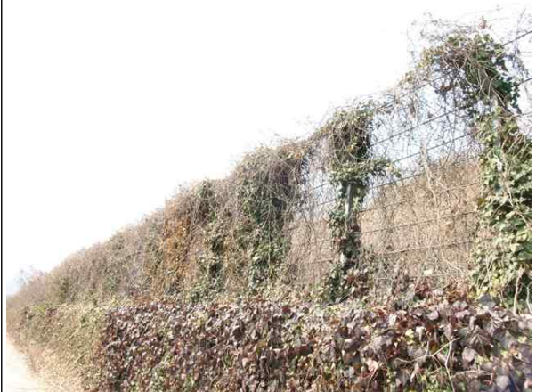
낙석방지울타리 및 하부 전경
